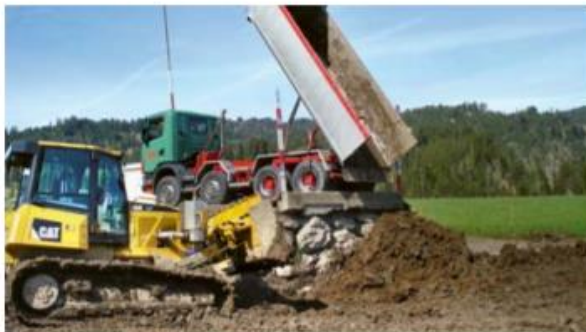
Foto 4: Verstossen des angelieferten Aushubmaterials (Foto AfU)
