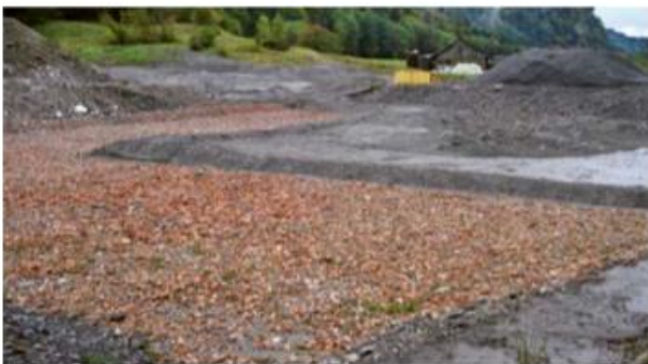
Foto 6: Sohlenvorbereitung mit Abdichtung und Sickerschicht (Foto AfU)
