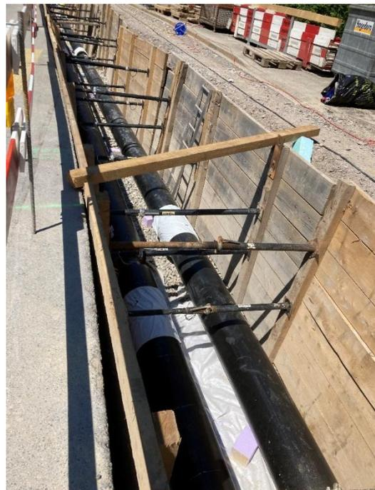
Fotobeilage: Fernwärmeleitungsbau in Pfäffikon
